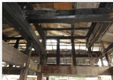
写真 1 福井県出身開拓民家仮組
